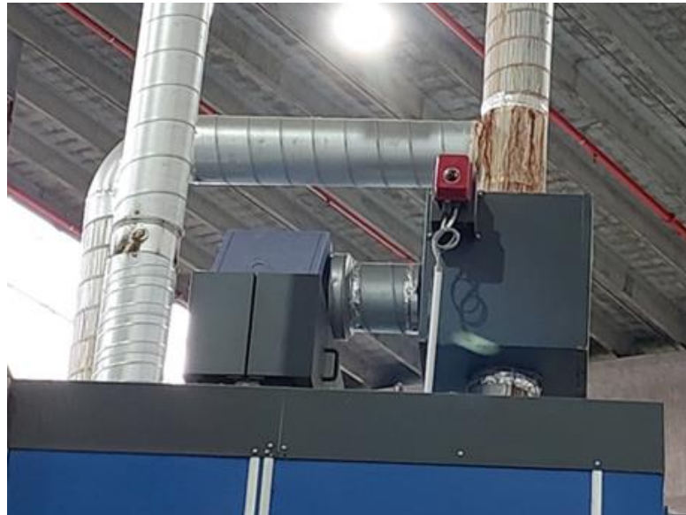
Lucht-water-warmtewisselaars voorzien op de moffeloven voor het hergebruik verloren warmte
